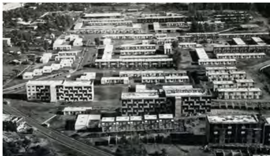
VUE AERIENNE PREMIERS GROUPES D'HABITATIONS, ALBANY OCTOBRE 1966, SIDR
